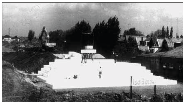
Slika 6. Primjer izgradnje nasipa od EPS geopjene (Hardinxveld-Giessendam, Nizozemska), [4]
