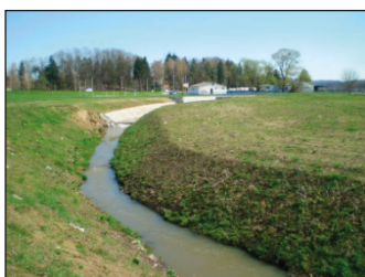
Slika 2. Dionica vodotoka Jelenska, nizvodno od mosta Zg-Kt (nakon izvršenih pripremnih radova)
