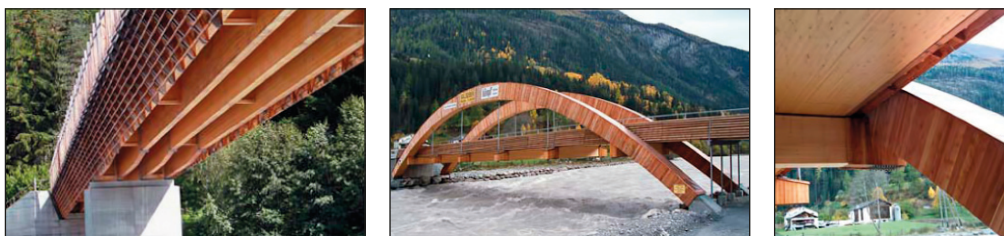
Slika 4. Pimjeri konstruktivne zaštita nosača oblogama od ariša
