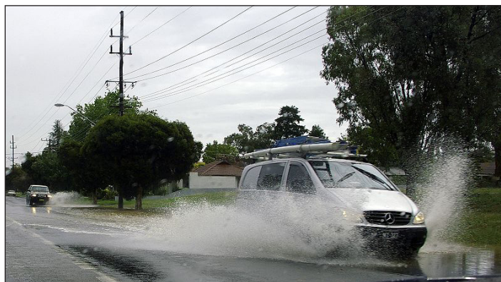
Slika 4. Problem zadržavanja vode na kolniku
