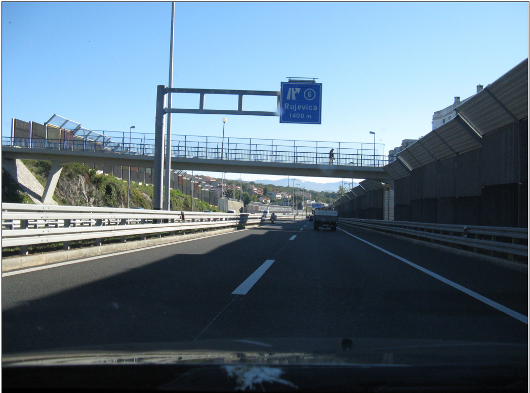
Slika 1. Fotografija mosta sa zapadne strane
