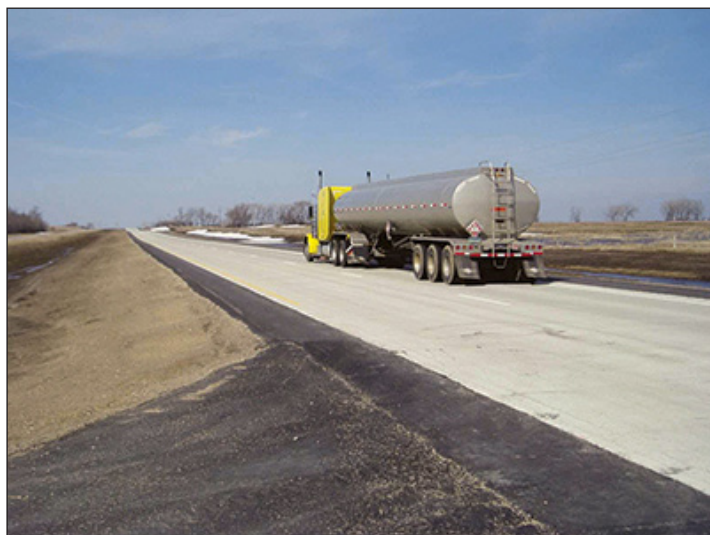
Slika 16. Primjer kolnika sa slojem whitetopping-a [13]
