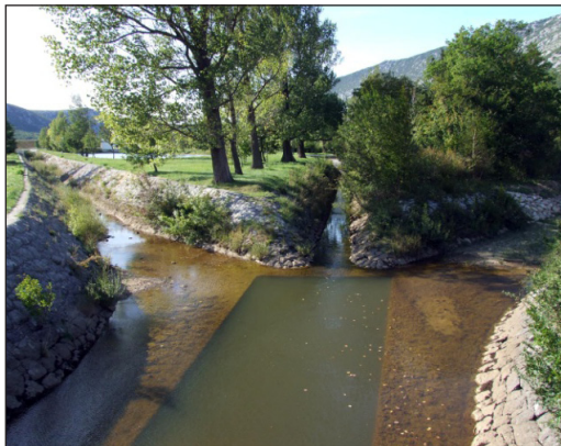
Slika 16. Dubračina na mjestu spajanja temeljnog ispusta akumulacija Donji bazen, odvodnog kanala HE Vinodol i kanala kojim dolaze vode s izvorišta Sušik
