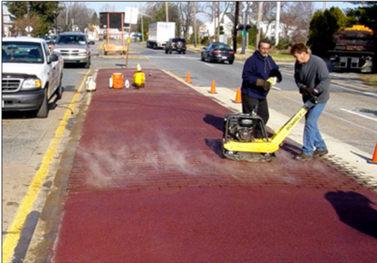
Slika 6. Primjer bojanog asfaltnog kolnika [7]
