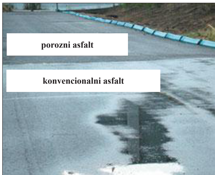
Slika 9. Primjer poroznog asfaltnog kolnika [8]
