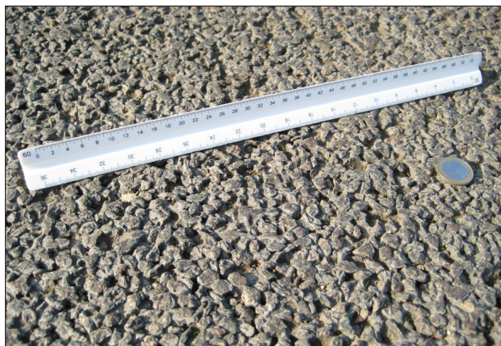
Slika 10. Primjer poroznog betonskog kolnika [9]
