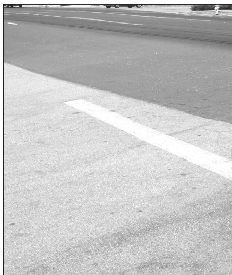
Slika 13. Primjer različite boje dijela kolnika na kojem je izvedena jednostruka površinska obrada (donji dio slike) i kolnika na kojem je zadržana stara asfaltna kolnička konstrukcija (gornji dio slike) [12]
