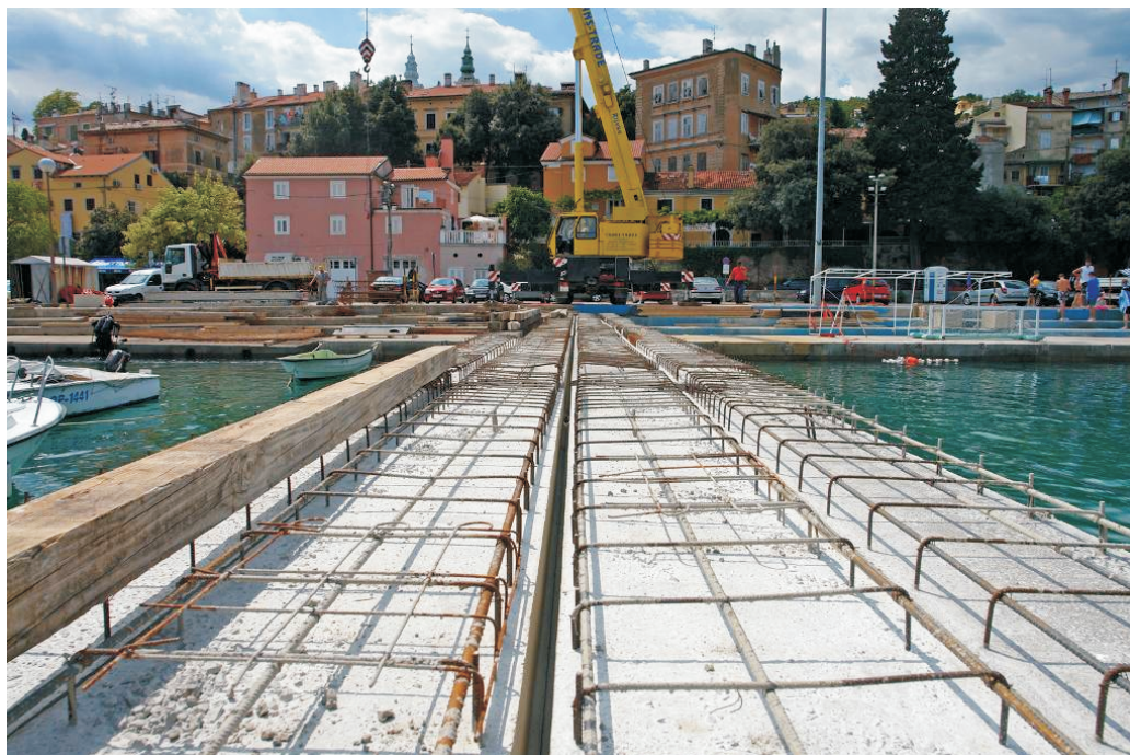
Slika 14. Predgotovljeni AB nosači rasponske konstrukcije
