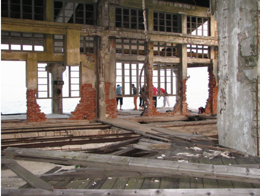
Slika 5. Detalj bočnih zidova lansirne rampe
