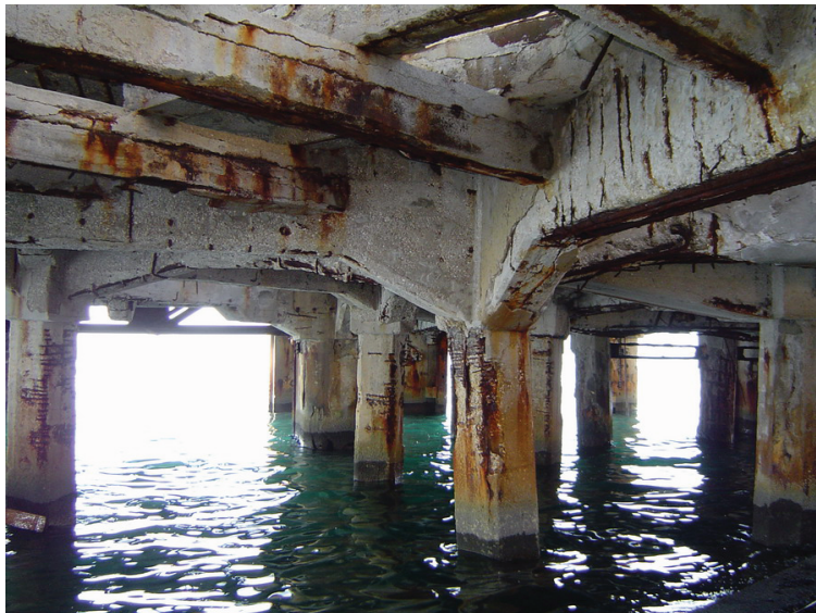
Slika 3. Detalj pilota i radne platforme odozdo
