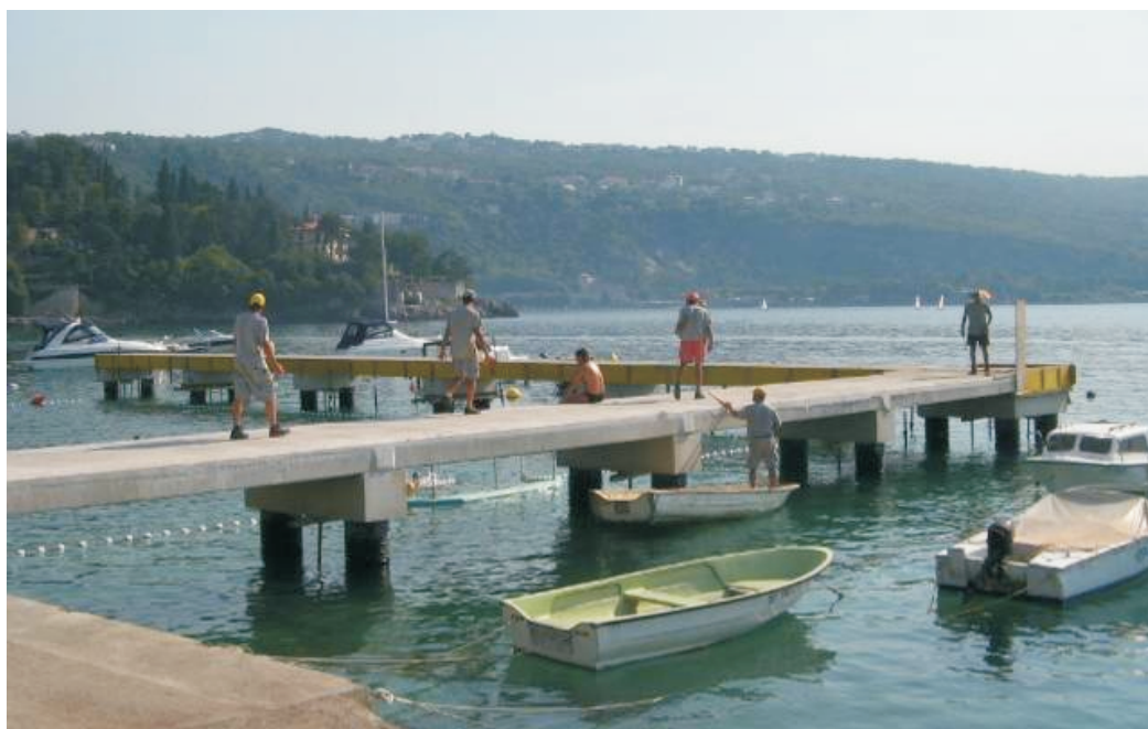
Slika 15. Završetak betoniranja tlačne AB ploče
