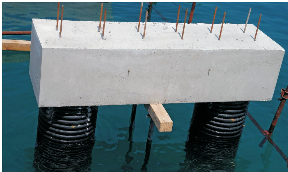
Slika 13. Stupovi i naglavna AB greda
