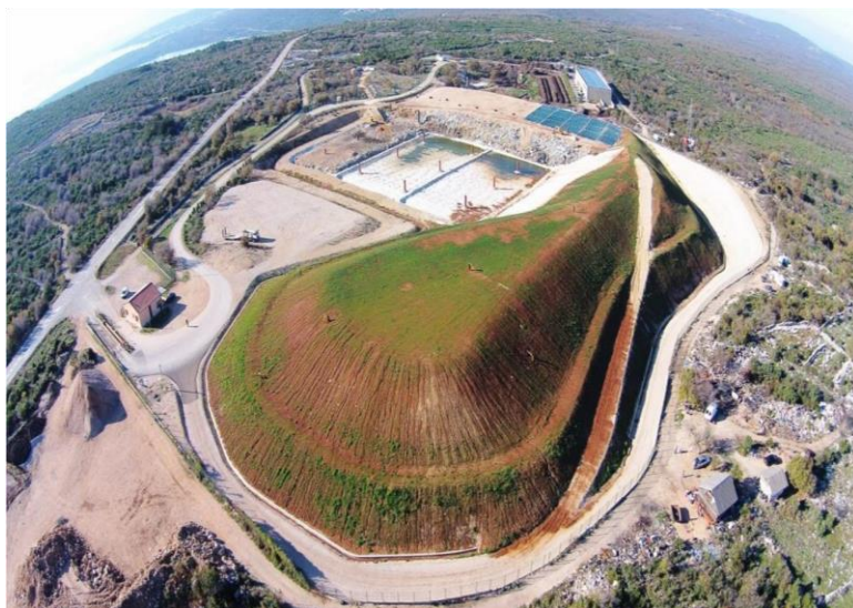
Slika 1. Odlagalište Treskavac nakon sanacije [11]
