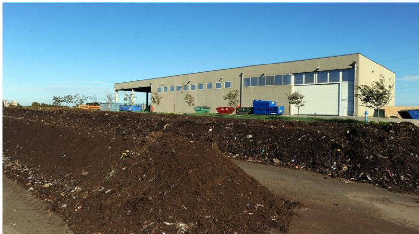
Slika 2. Hala za prihvat i razvrstavanje otpada sa kompostanom [11]
