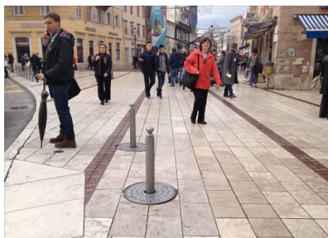
Slika 11. Nove daljinski nadzirane automatske barijere (hidraulički stupići) postavljene u sklopu provedbe projekta
