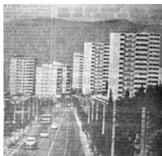
Slika 11. Stambeni tornjevi uz Liburnijsku ul. po izgradnji [29]
