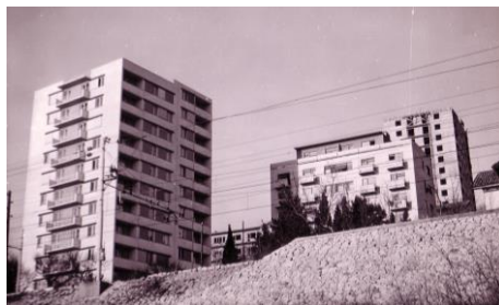
Slika 6. Stambeno naselje Ogranak u izgradnji, suvremena fotografija
