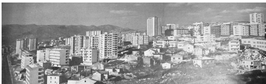
Slika 9. Stambeno naselje Turnić u izgradnji, stanje 1961. [21]
