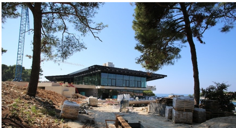
Slika 14. Izvedba radova na novom Hotelu Park (Matan C., 09.2018.)
