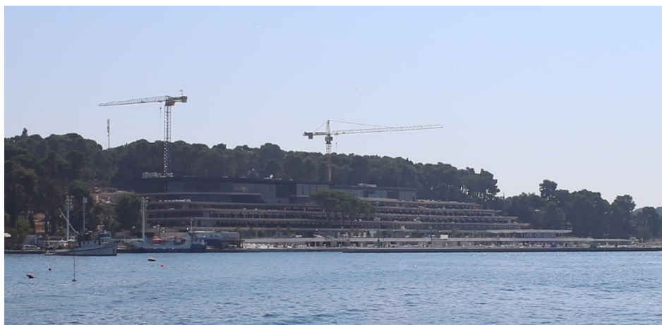
Slika 9. Hotel Park tijekom izgradnje (Matan C., 09.2018.)
