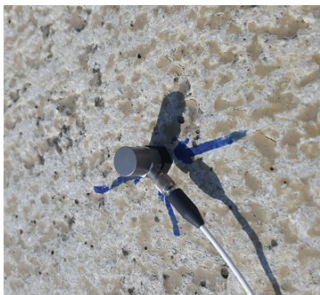
Slika 19. Pričvršćenje akcelerometra na konstrukciju
