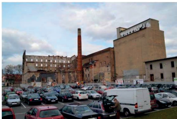
Slika 1. Postojeće stanje konstrukcije Paromlina [12]
